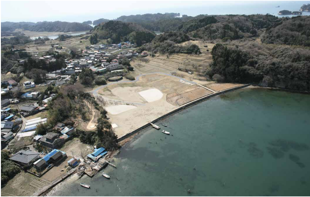
台囲東地点遠景 (整備後、北東から)
